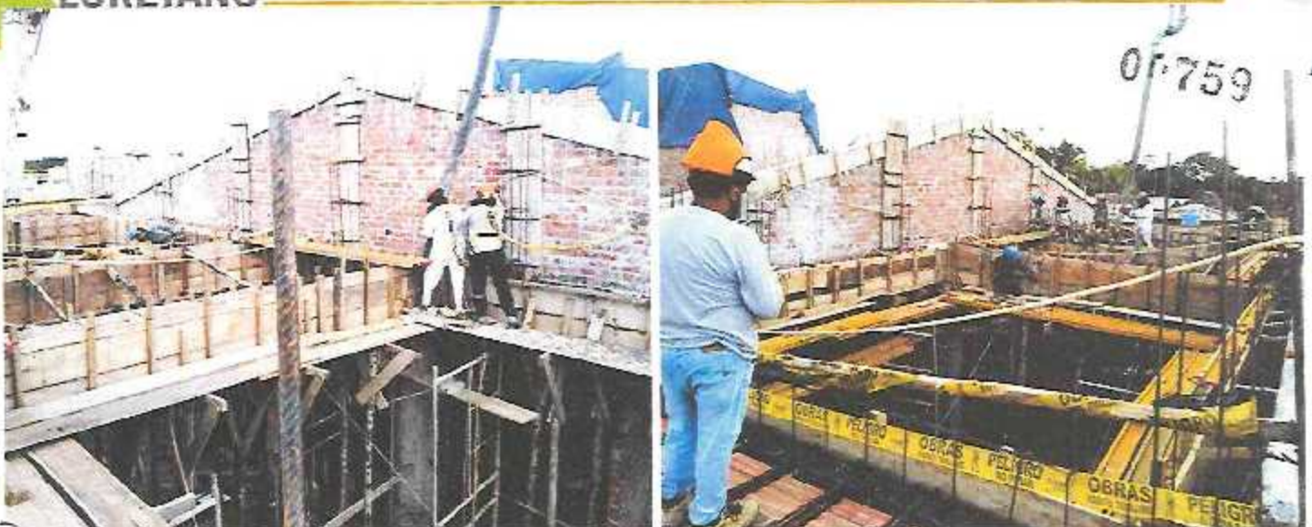
Vaciado de concreto de vigas, voladizos y otros en el Módulo A-1 / Bloque 3 con bomba telescópica.
