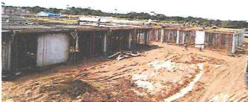
Vista de trabajos en losas del Módulo B-2 y C-2.
