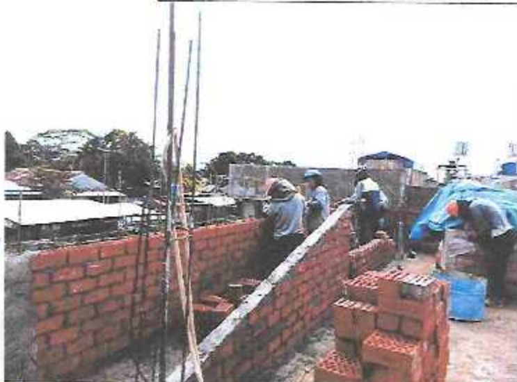
Asentado de ladrillo 18 huecos en parapetos y encofrado y vaciado de columnetas de amarre en Módulo A-2.
