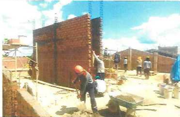
Encatado de columnas en los ductos del Sector A-1, Bloque A-4.
