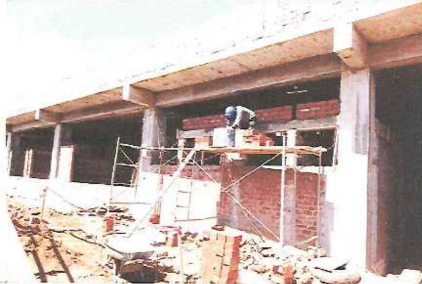
Asentado de ladrillo 18 huecos en aparejo de soga en muros del Módulo D (2° parte).
