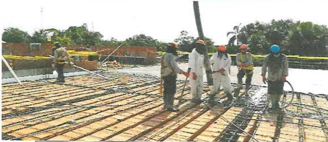
Vaciado de concreto f'c = 210 \text{ Kg/cm}^2 de losa aligerada en uno y dos sentidos en el Bloque A-6.
