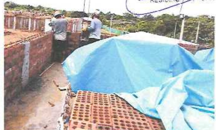
Asentado de ladrillo 18 huecos en parapetos y encofrado y vaciado de columnetas de amarre en Módulo A-2.
