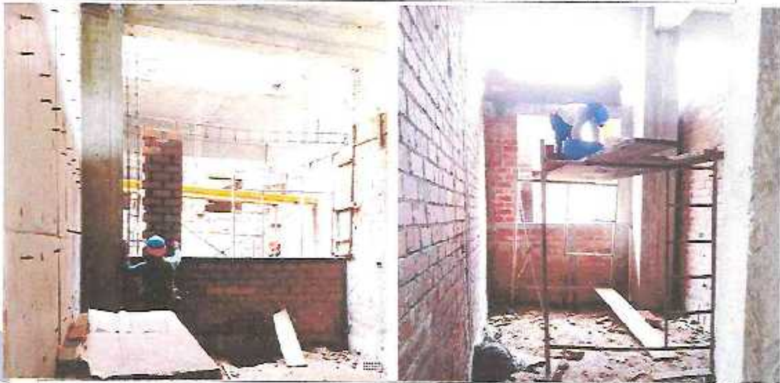
Trabajos de encofrado de columnetas y vigas de confinamiento en interior del Módulo D (2° parte).
