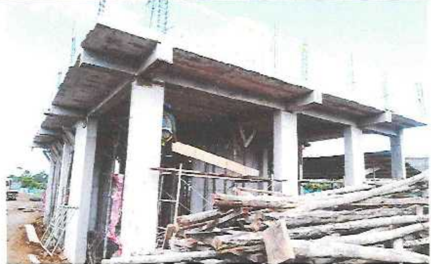
Trabajos de desencofrado de losa aligerada en el Módulo A-2.
