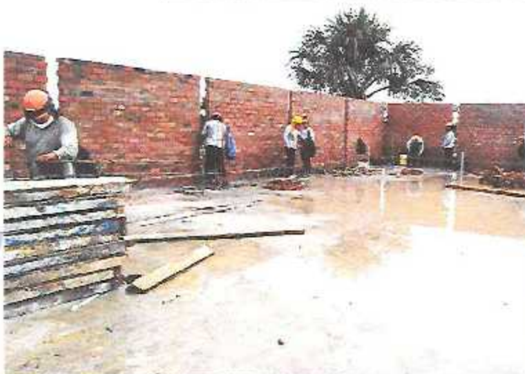
Habilitado de acero estructural para columnetas de amarre y vigas de confinamiento en parapetos del Módulo A-1 / Sector 6.
