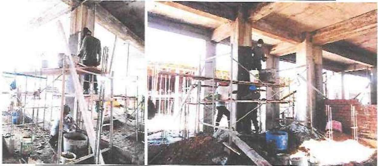
Tarrajeo de superficie de columnas en el Módulo D (2° parte).
