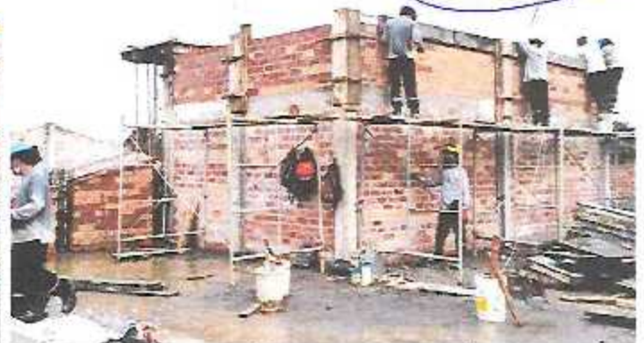
Encofrado de columnas y vigas de confinamiento en ductos del Módulo A-1 / Sector 4.
