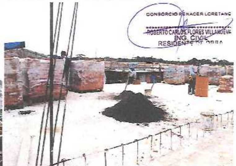
Encofrado de sobrecimientos reforzados y asentado de ladrillo 18 huecos en parapetos del Módulo A-2.
