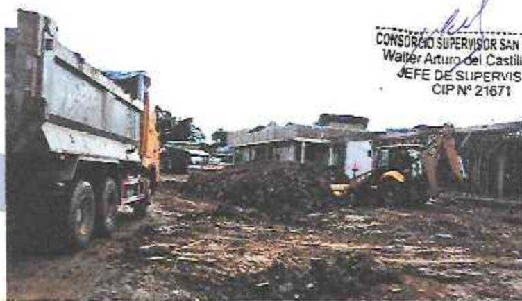
Eliminación de excedentes de obra producto de los trabajos de corte a nivel de subrasante.
