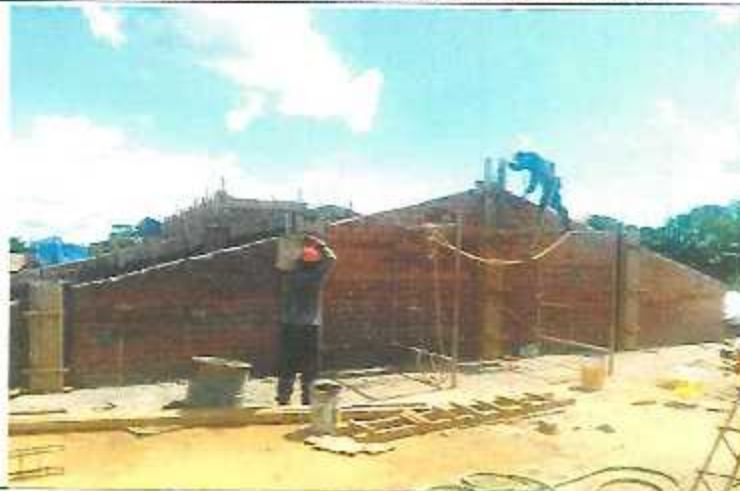
Encatado y vaciado de columnetas en tirpanas del Sector A-1, Bloque A-2.
