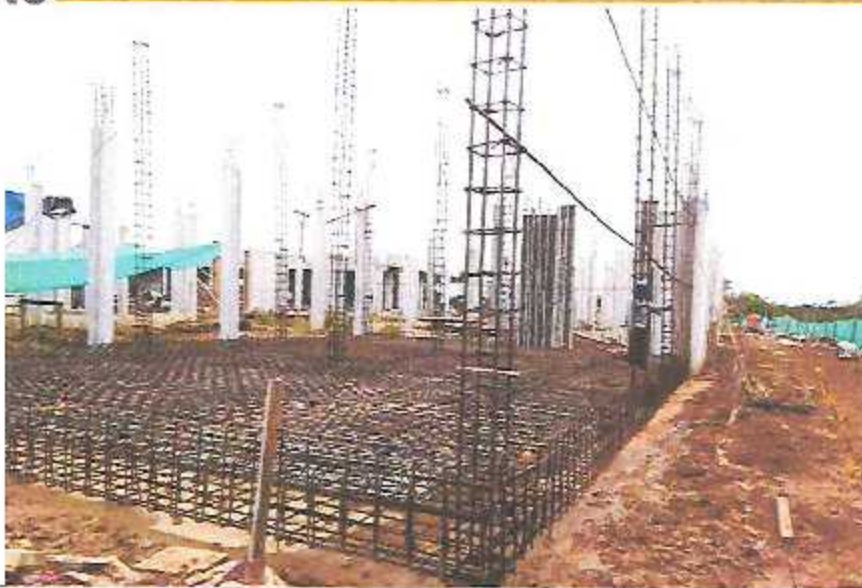
Habilitado de acero estructural en pletaa y muros armados de la cisterna en el Módulo E-3.
