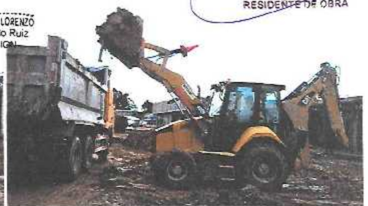
Eliminación de excedentes de obra producto de los trabajos de corte a nivel de subrasante.
