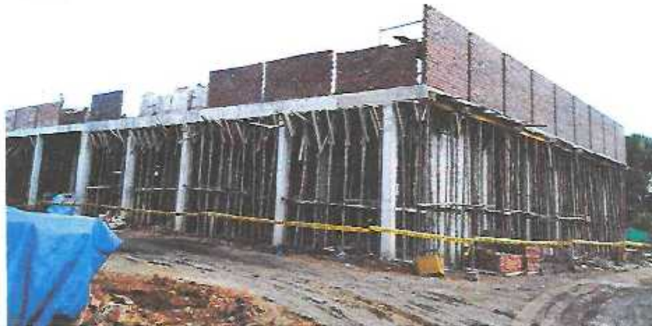
Asentado de ladrillo 18 huecos en parapetos del Módulo A-1 / Sector 6.
