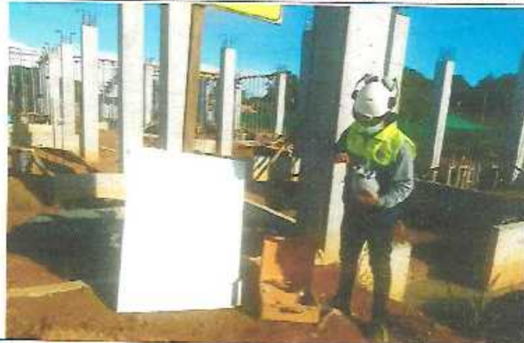
Ensayo de Saturación de Suelos en diversos sectores de la obra con fines de verificación.
