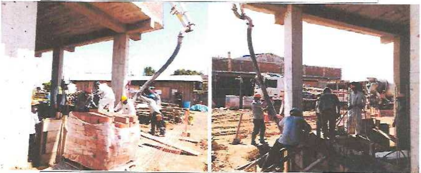
Vaciado de concreto f_c = 175 \text{ Kg/cm}^2 para sobrecimientos reforzados con bomba telescópica en Módulo A-2.
