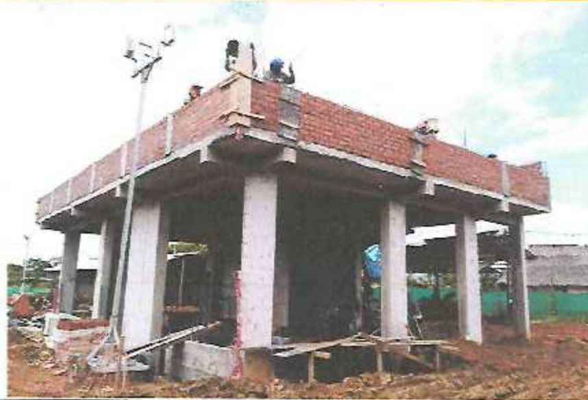
Asentado de ladrillo 18 huecos en parapetos y encofrado y vaciado de columnetas de amarre en Módulo A-2.
