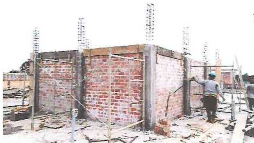
Encofrado y vaciado de concreto f_c = 175 \text{ Kg/cm}^2 en columnas y vigas de confinamiento en ductos del Módulo B-1.
