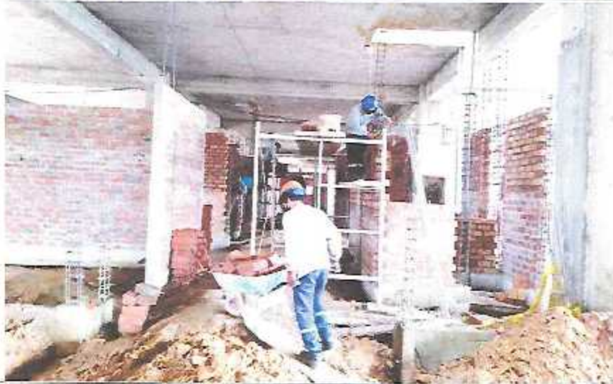
Asentado de ladrillo 18 huecos en muros interiores del Módulo D (2° parte).
