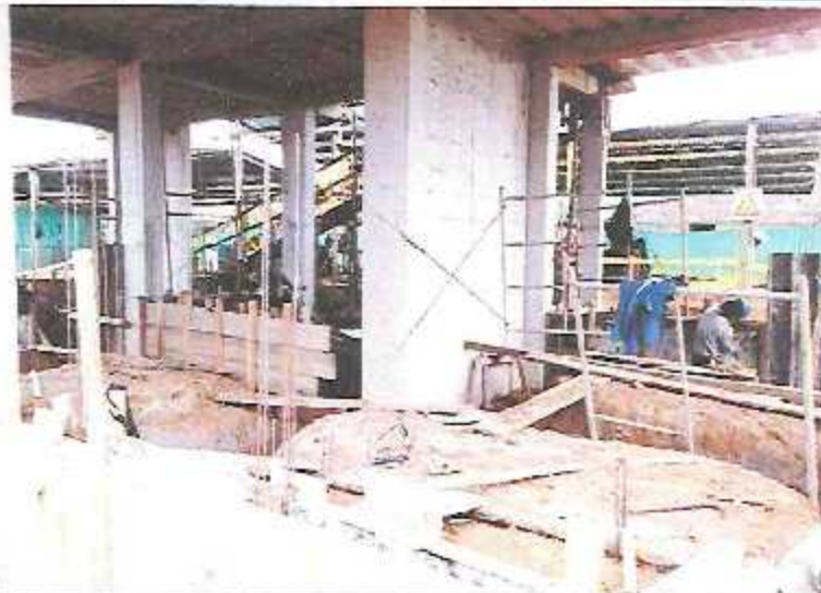
Encofrado de sobrecimientos reforzados en el Módulo A-2.
