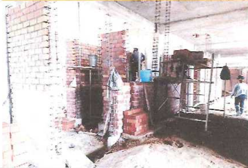
Asentado de ladrillo 18 huecos en muros interiores del Módulo D (2° parte).
