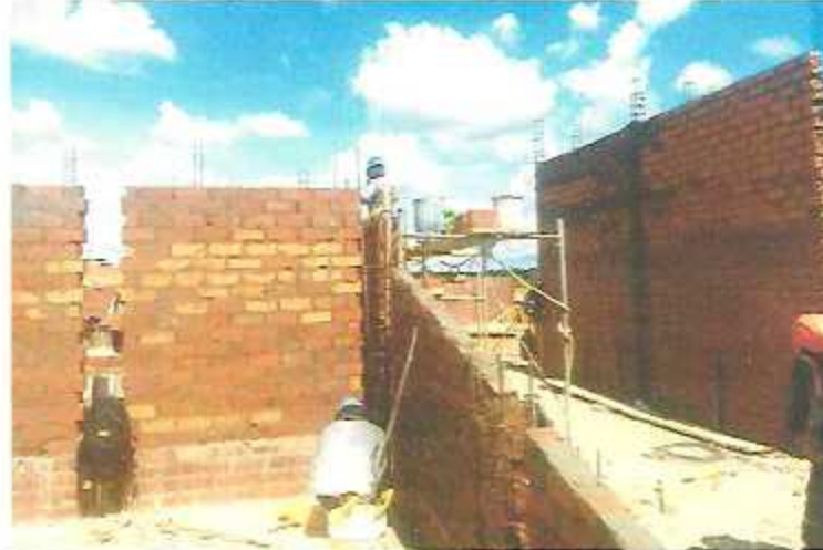
Asentado de ladrillo king kong en parapetos de ductos del Sector A-1, Bloque A-4.
