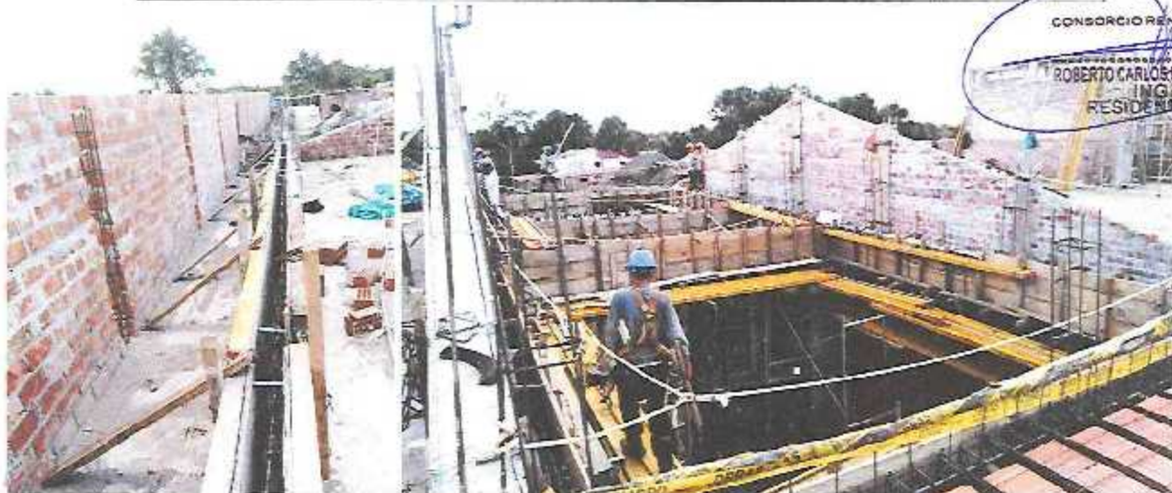
Encofrado de parapeto armado y vaciado de concreto en vigas, voladizos y otros en el Módulo A-1 / Bloque 3.
