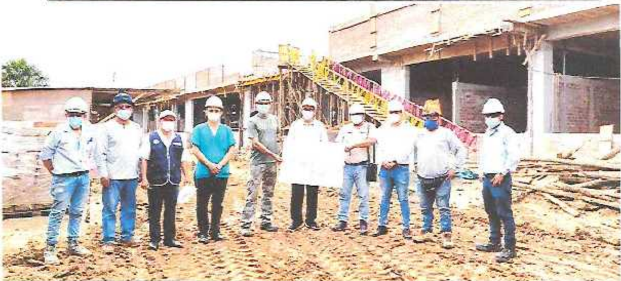
Visita de funcionarios del Gobierno Regional de Loreto a las instalaciones de la Obra del Hospital San Lorenzo.
