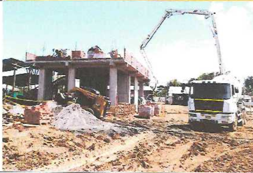
Vaciado de concreto f_c = 175 \text{ Kg/cm}^2 para sobrecimientos reforzados con bomba telescópica en Módulo A-2.
