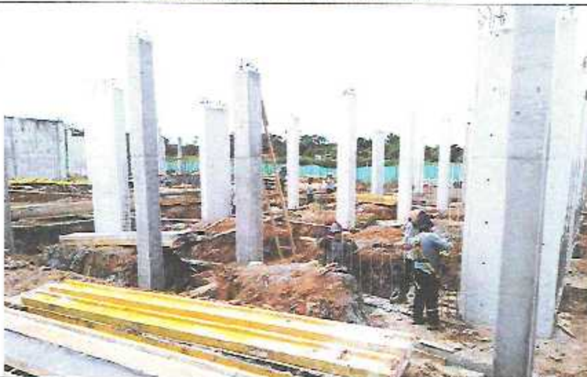
Habilitado de refuerzo de acero para cimentos reforzados en el Módulo E-4.
