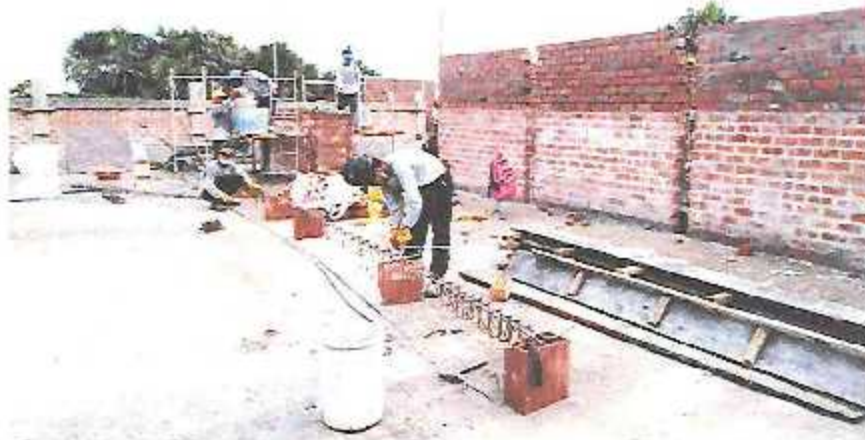
Habilitado de acero estructural para columnetas de emarre y vigas de confinamiento en parapetos del Módulo A-1 / Sector 6.
