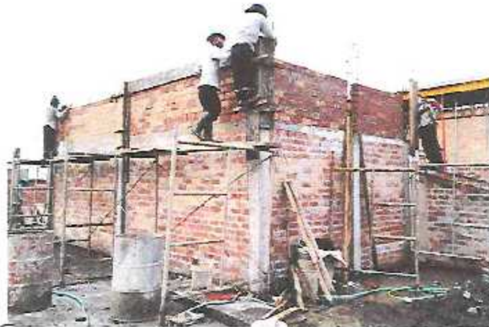
Encofrado de columnas y vigas de confinamiento en ductos del Módulo A-1 / Sector 4.
