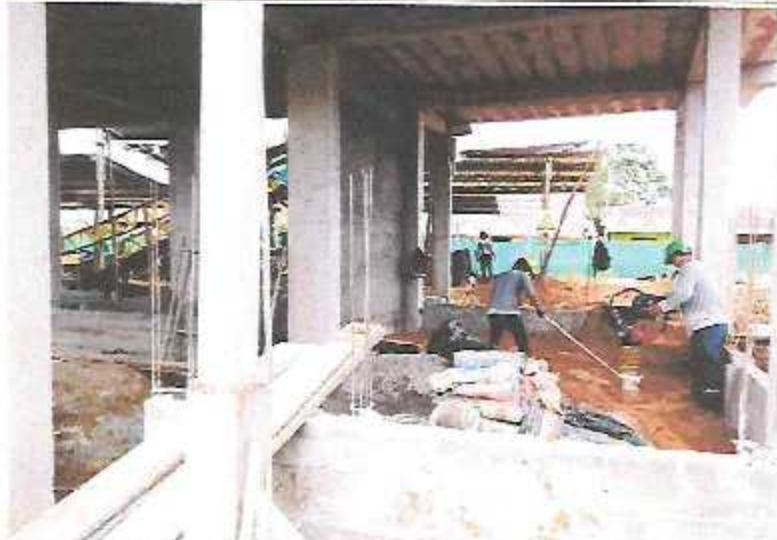
Relleno con material propio y apisonado con canguro en Módulo A-2
