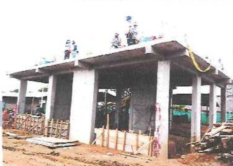
Encofrado de sobrecimientos reforzados y asentado de ladrillo 18 huecos en parapetos del Módulo A-2.
